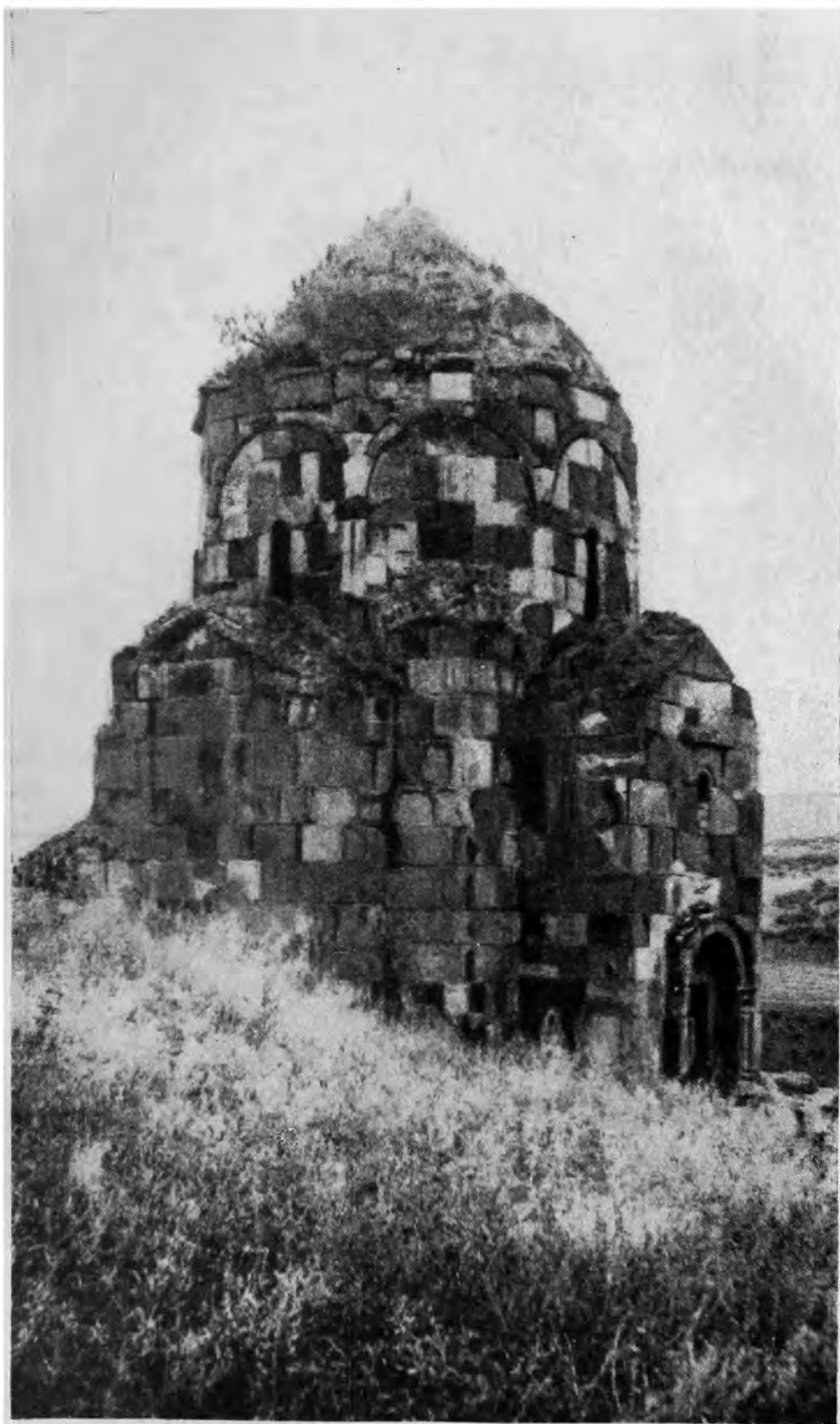
Рис. 15. Общий вид здания с сев.-зап. стороны
