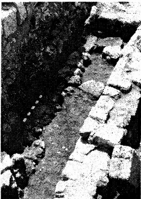
Дренажный водосток в портовом районе города
