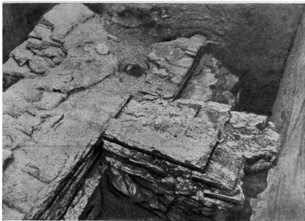
Рис. 11. Фундамент южной стены и южного притвора храма.
