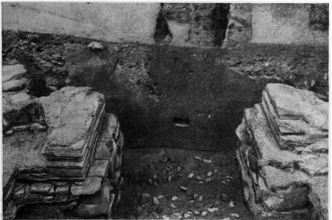
Рис. 10. Церковь Спаса на Берестове. Фундамент столба п южной стены.
