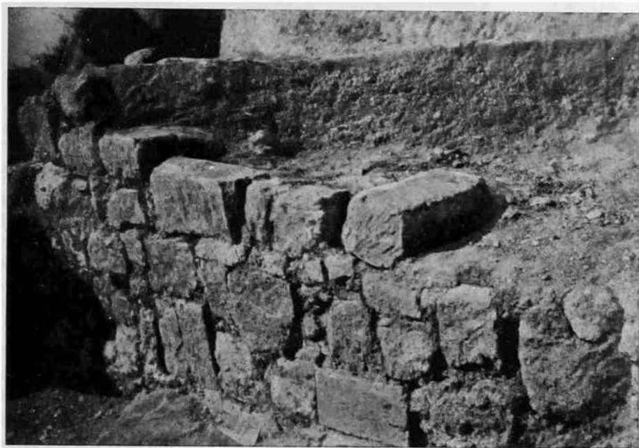
Рис. 3. Подпорная стена на восточном склоне горы Митридат.
