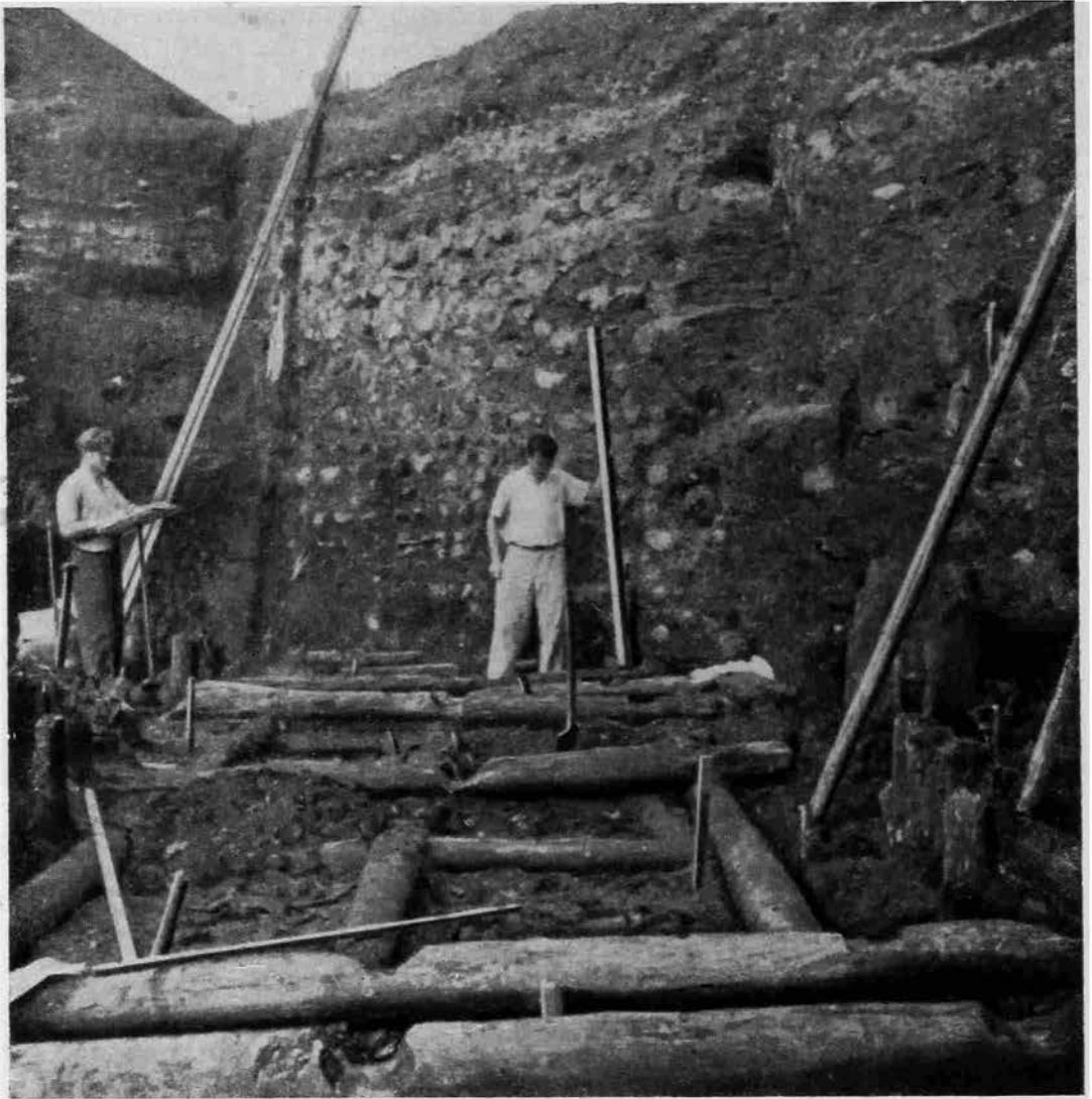
Рис. 7. Мостовая 23-го строительного яруса.
