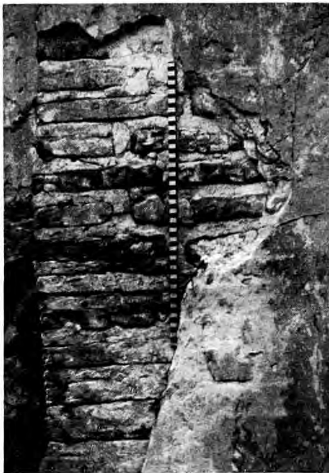
Рис. 11. Порядовая кладка юго-восточного пилона.
