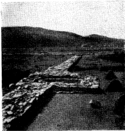
Рис. 4. Одна из промежуточных башен северо-западной крепостной стены
