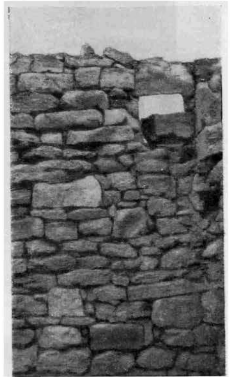
Рис. 11. Оконный проем, частично освобожденный от каменного заклада. Внутренний вид.
