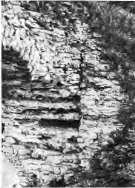
Рис. 15. Разнохарактерные кладки слоев юго-восточной стены с южной стороны выхода
