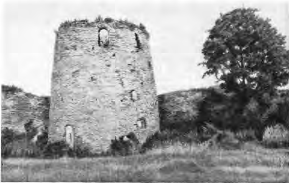
Рис. 16. Башня Луковка. Общий вид
