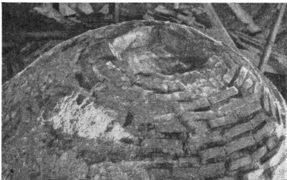
Рис. 11. Церковь Петра и Павла в Кожевниках 1406 г. Новгород. Верхняя часть купола.
