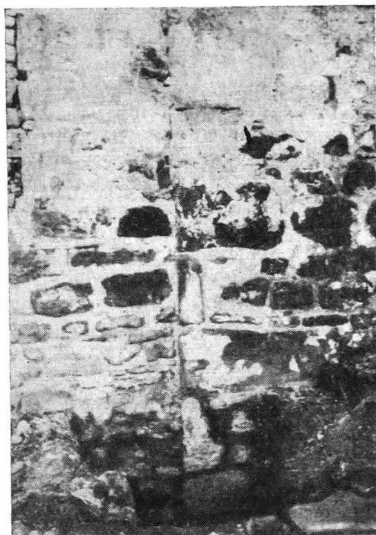
Рис. 6. Строительный шов в северной стене храма (см. план)
