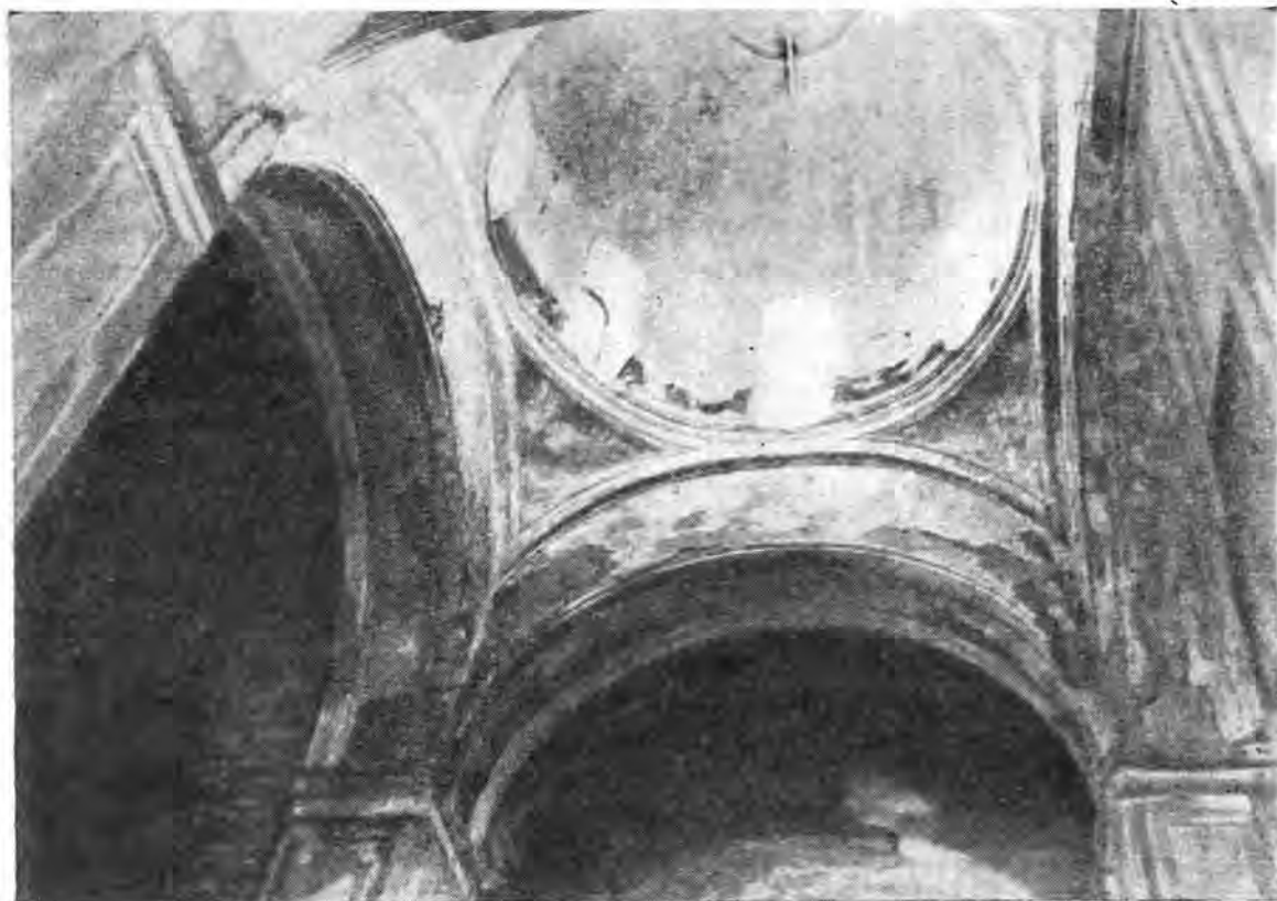
Рис. 5. Устоп, подпружные арки и пандативы. Снимок 1965 г.
