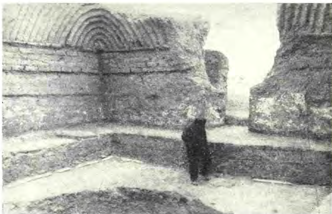
Рис. 14. Дальверзин. Помещение с бассейном в юго-западном комплексе
