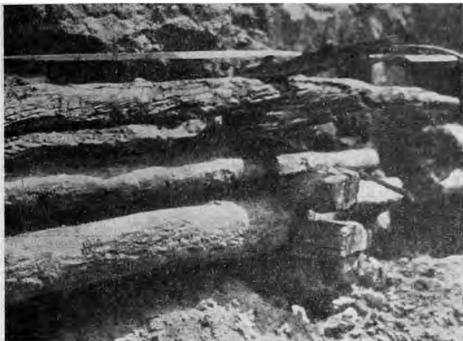
Рис. 4. Угол среднего сруба. Рубка «в обло»
