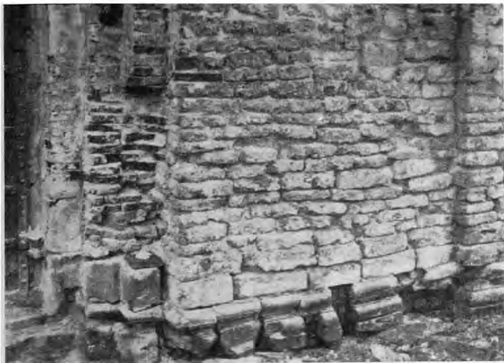
Рис. 2. Кладка из ноздреватого известняка нижней части собора 1148 г.
