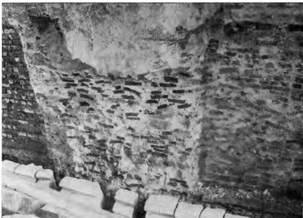
Рис. 1. Кладка стены мономахова собора за туфовой облицовкой 1148 г.
