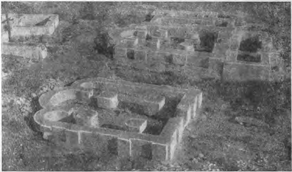
Рис. 3. Фундаменты средневековых зданий в Довмонтовом городе во Пскове. 1 — после раскопок Г. П. Гроздилова; 2 — после восстановления и музеефикации (фото Б. С. Скобельцына)
