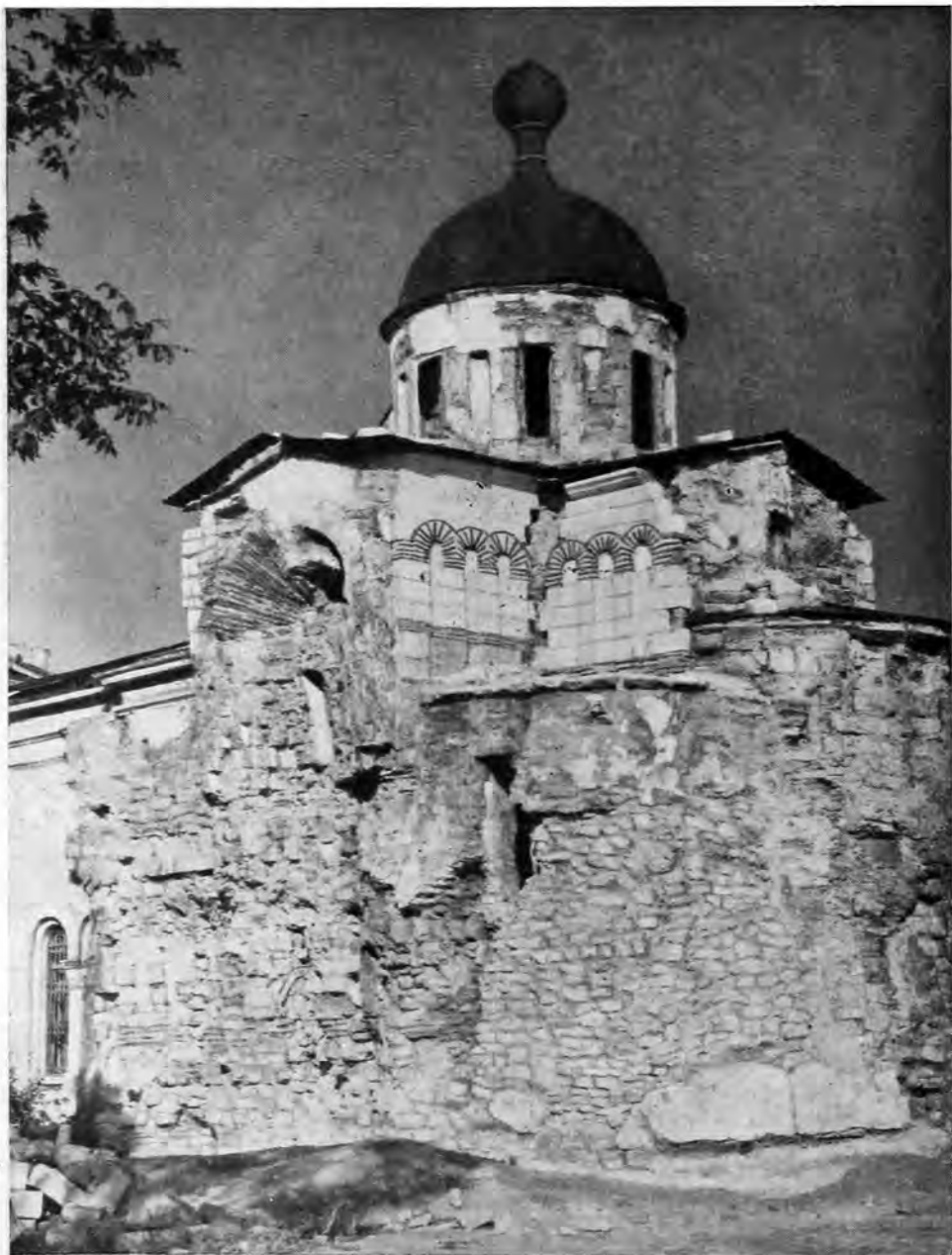
Рис. 1. Церковь Иоанна Предтечи в Керчи в процессе реставрации
