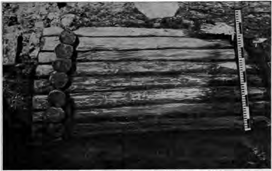
Рис. 2. Постройка 41. Вид с запада
