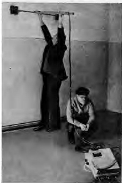
Рис. 6. Зондирование стен помещения в Вентспилском замке
